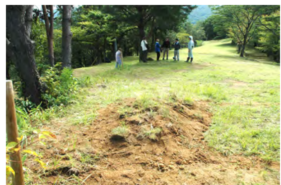
2301 トレンチ 埋め戻し状況
